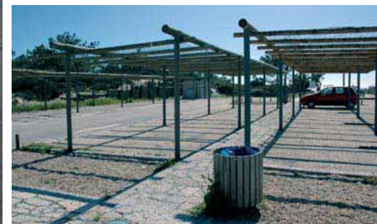
INFRA-ESTRUTURAS NOS ACESSOS ÀS PRAIAS Uma intervenção em equilíbrio com o ambiente
